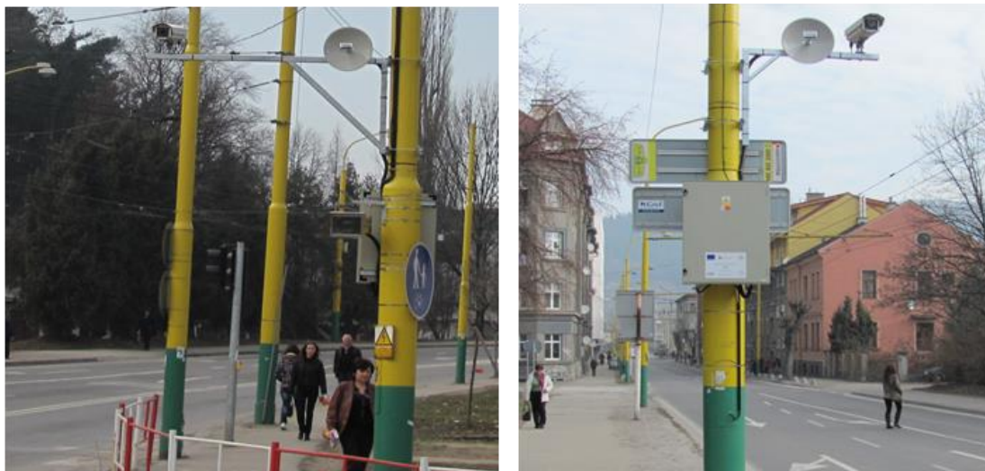
Obrázok 2: Umiestnenie kamier systému UnicamREDLIGHT (detailná kamera - vľavo; prehľadová kamera - vpravo)
